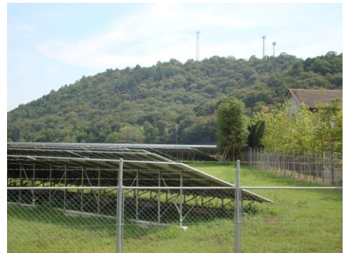
写真：パネル設置状況 (右手が原告宅) 筆者撮影
